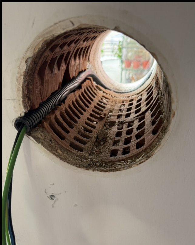
/// ATTRAVERSAMENTO VENTILAZIONE
